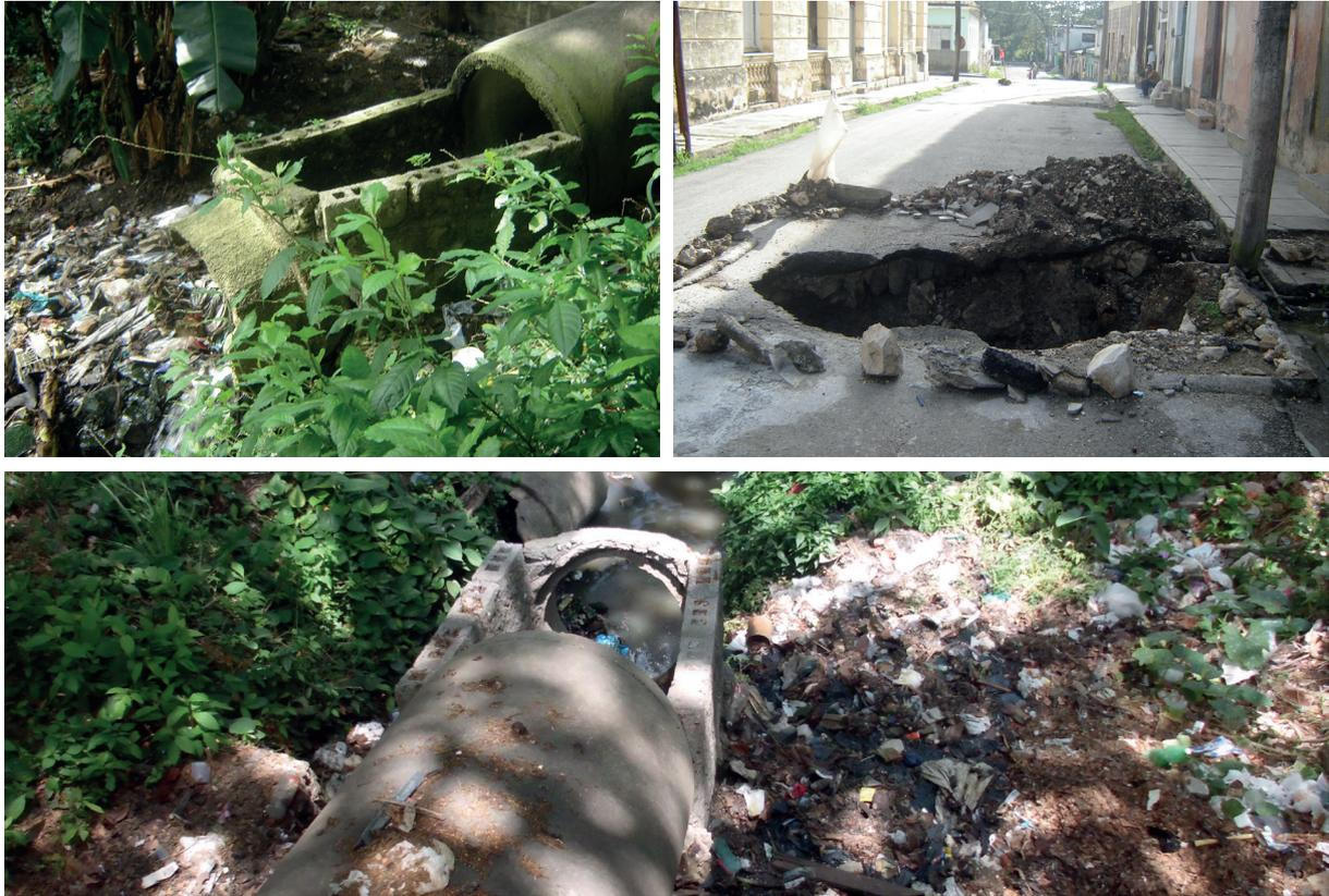
Figura 37. Deficiente estado de la red de alcantarillado de la ciudad.
